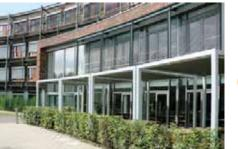
Eine Schräge für alle Fälle: Die Dachmarkise lässt sich absenken, so dass Regenwasser einfach ablaufen kann. Die vertikale Markise eignet sich auch hervorragend zur Beschriftung.
